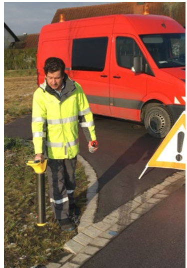
Abb. 5 Leitungssuche mit Ortungsgerät
