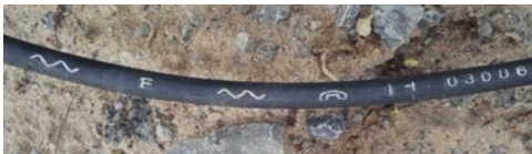
Abb. 2 Glasfaser-Telekommunikationsleitung mit „Wellenlinie“
