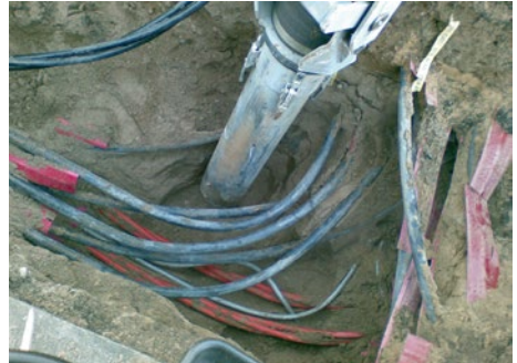
Abb. 9 Saugrohr im Einsatz
